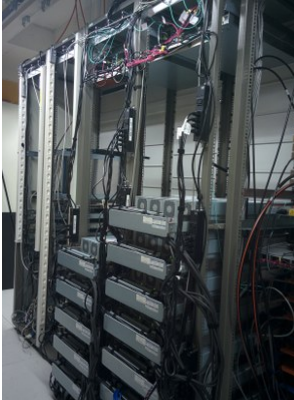
Installation terminée, vue arrière
