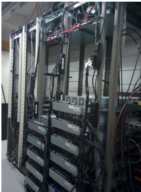
Installation terminée, vue arrière
